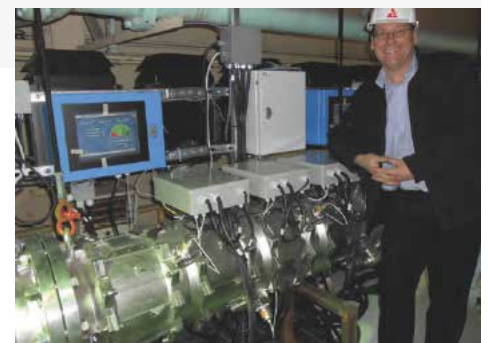
Hydro-Optic Instalación de Decloración en Plant Bowen, Georgia USA
